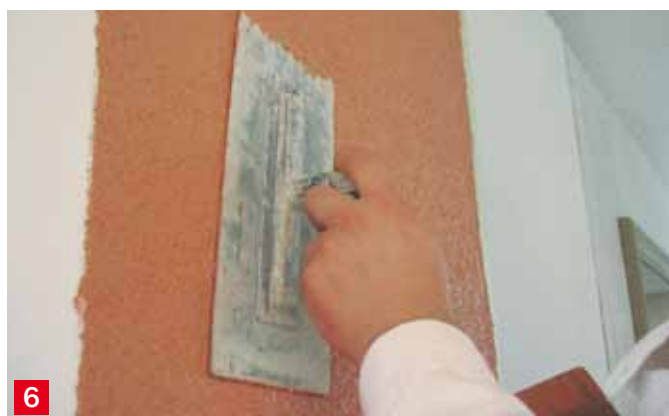
6 Решение 3б: Нанасяне на фасадна мазилка.
