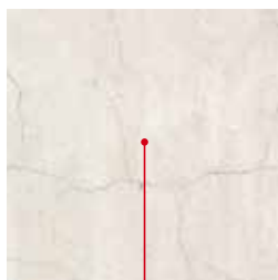
ФАСАДА С ПУКНАТИНИ ПО-МАЛКИ ОТ 0,5 мм
